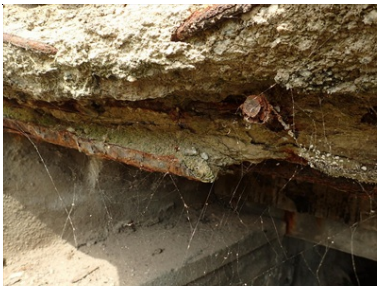
Podhled NK rozšíření pod chodníkem na styku s původní římsou. Odpadlé bednění, styčná spára s původní římsou vyplněna kameny a nečistotami.
