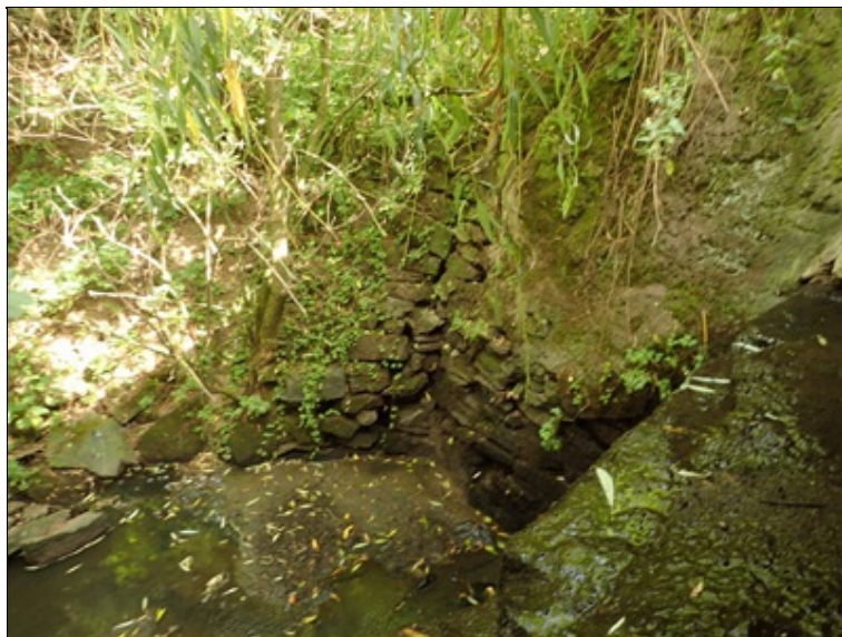
Pata dřívku pravého křídla O1 pod stupněm v korytě.
