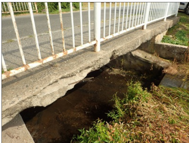
Levý bok rozšířené NK podporující chodník.
